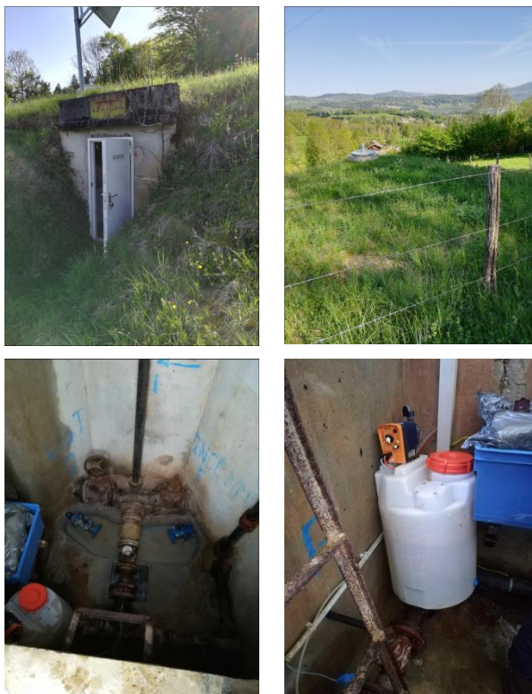
Figure 3 : Réservoir de Lépin-le-Lac - Photographies
